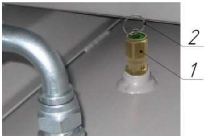
Рисунок 9 – Клапан предохранительный пружинного типа
